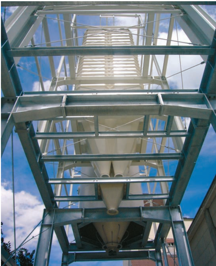
Abb. 10: Stahlbau bei der Montage der Silozellen
