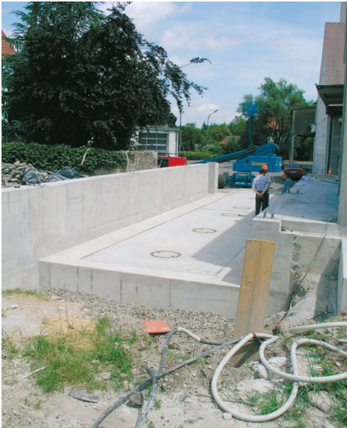
Abb. 9: Fundamentplatte mit Anfahrschutz und Fahrzeugwaage
