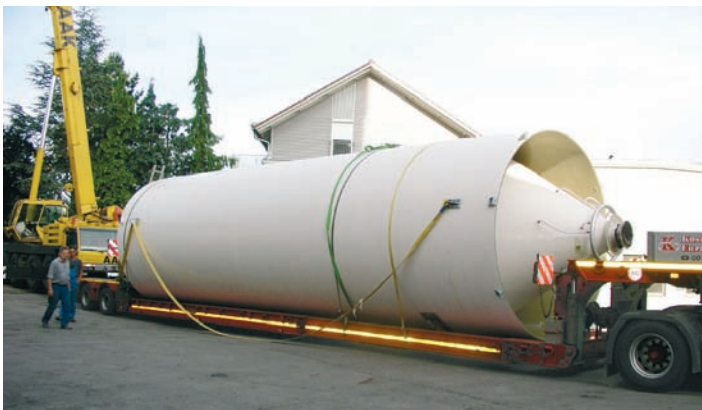
Abb. 2: GFK-Silozelle, \varnothing 3,5 m, bei der Anlieferung auf einem Tieflader
