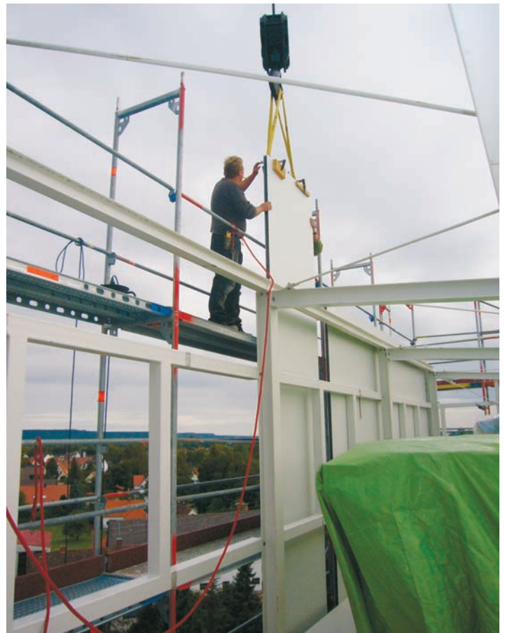
Abb. 11: Verkleidung aus Isopaneelen bei der Montage
