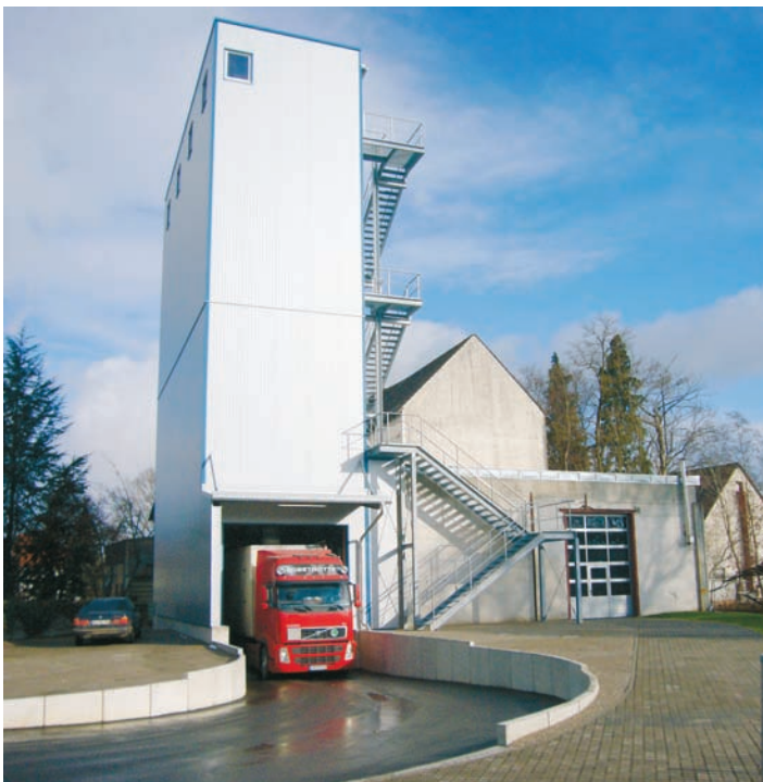
Abb. 7: Fertig verkleidete Loseverladung mit Isopaneelen und Zugangstreppe
