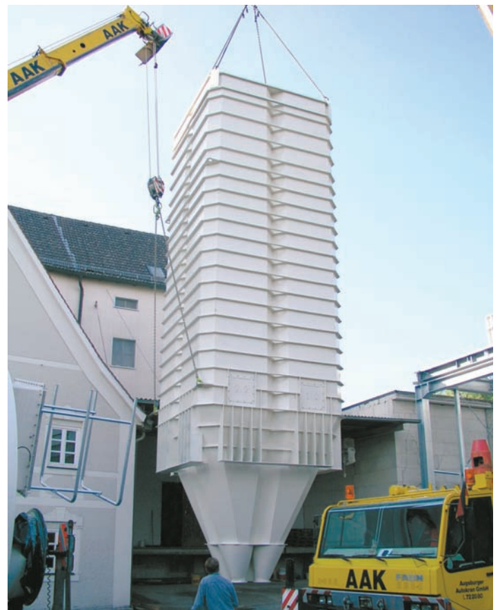
Abb. 3: Vierteiliger Stahlsiloblock für Mehl bei der Montage
